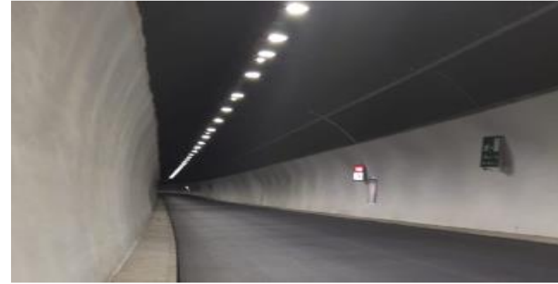
Client: SOCIETÀ AUTOSTRADA LIGURE TOSCANA S.P.A. Description: Fostering Gallerie SALT Lotto A, Lotto B
