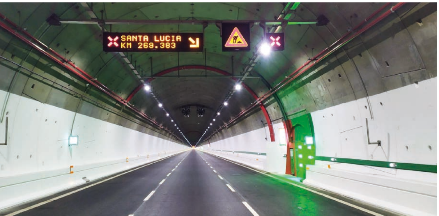
PAVIMENTAL S.P.A. Galleria Santa Lucia
