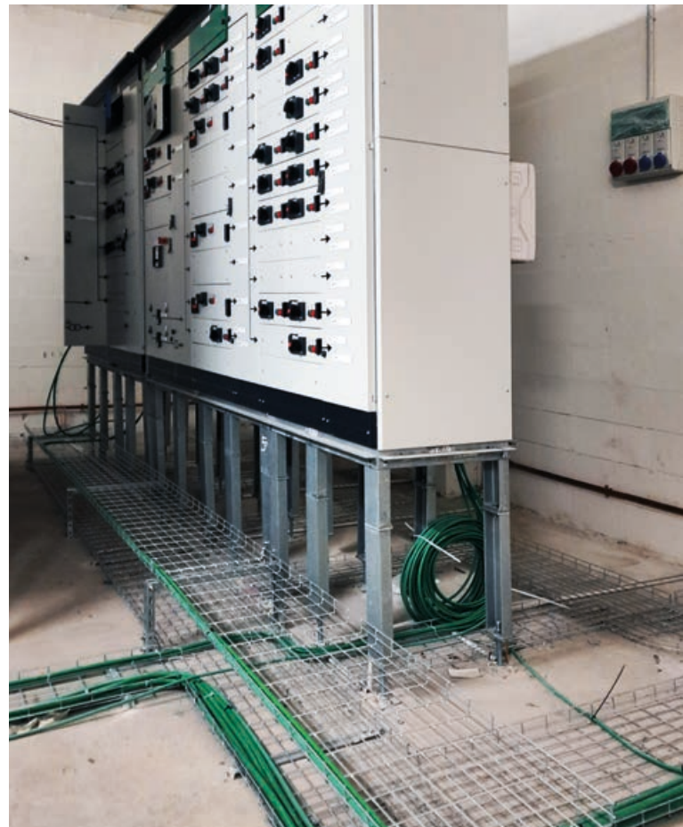
SOCIETE FRANCAISE DU TUNNEL ROUTIER DU FREJUS Tunnel autostradale del Frejus - Francia
